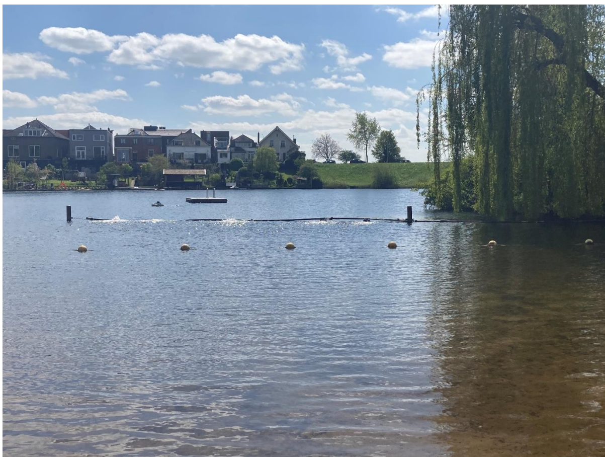
Foto 1: Beluchtungsleiding in de zwemzone.
