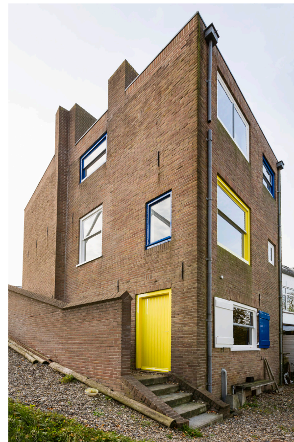
Karakteristiek 2: huis neemt schuinte dijk op in plattegrond, er wordt niet aangedijkt
