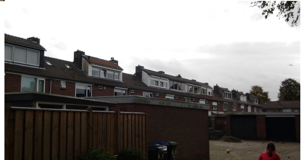
Afbeelding 63: Rij met nokverhogingen gezien vanaf de achterzijde, GOED: ritmiek van de schoorstenen is behouden, GOED: hoogte borstweringen, gebruik van glas als gevelmateriaal
