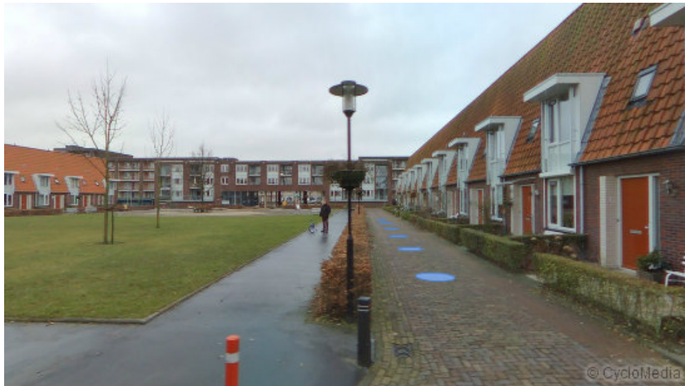
Afbeelding 36: Ruimtelijke samenhang door doorlopende nok, ritme van dakkapellen en rode deuren en hagen in de Drentse hof
