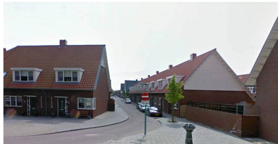
Afbeelding 34 en 35: Lage woningen met grote dakvlakken, Delftse stoepen, ritmiek van de schoorstenen en dakkapellen, rode pannendaken en het gebruik van witgeschilderd hout bepalen het aangezicht van Nieuw-Kinderdijk
